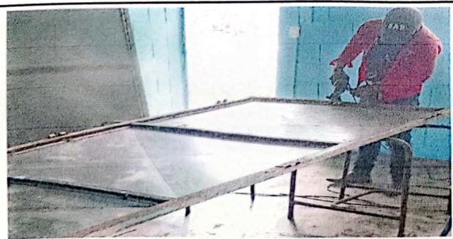
**Foto 5: Remozamiento de portones y puertas y aplicación de pintura anticorrosiva**
