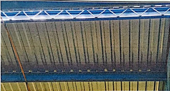
**Foto 3: Colocación de Techo con Láminas troqueladas**
