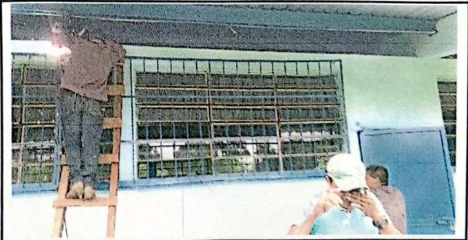
**Foto 6: Remozamiento de Ventanas y colocación de Balcones**
